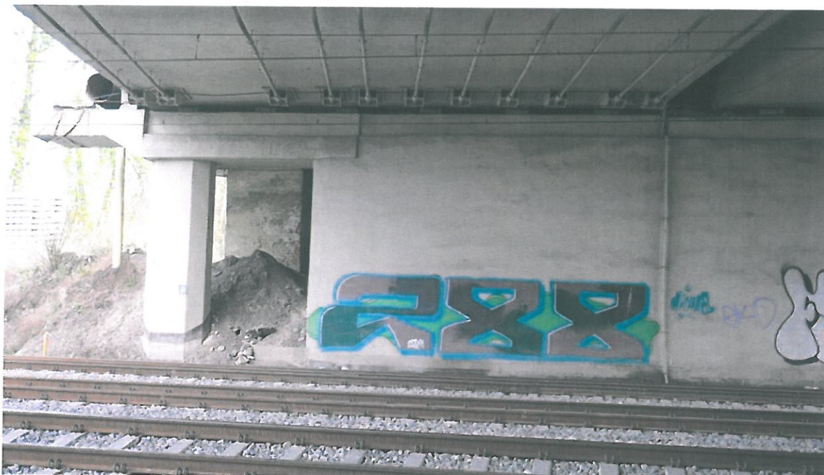
Fot. 18. Widok ogólny na przyczółek estakady zachodniej od strony Bytomia.
