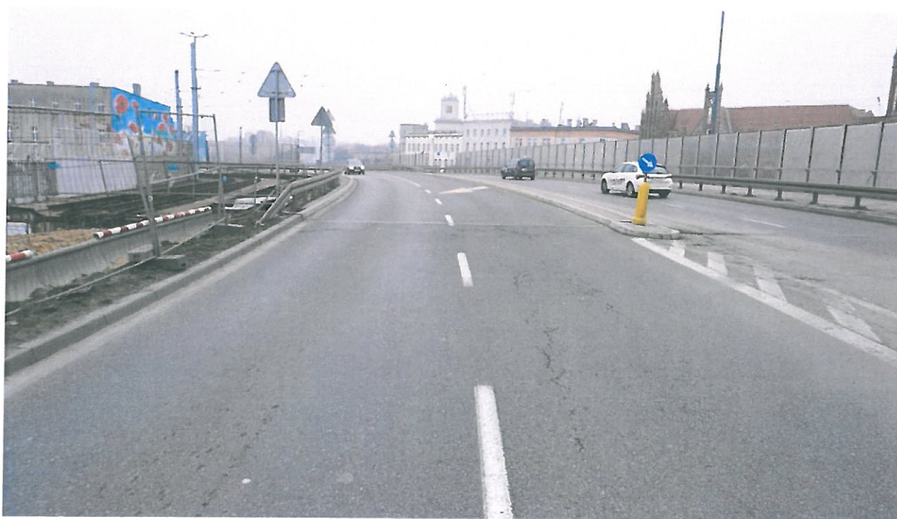
Fot. 5. Widok dojazd do estakady wschodniej patrząc w kierunku Katowic.
