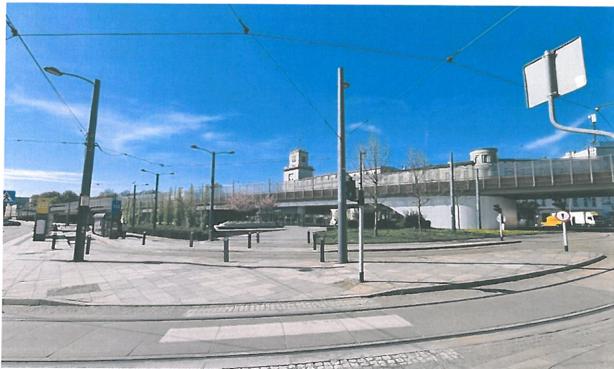
Fot. 2. Widok estakady wschodniej z boku między P7, P8.
