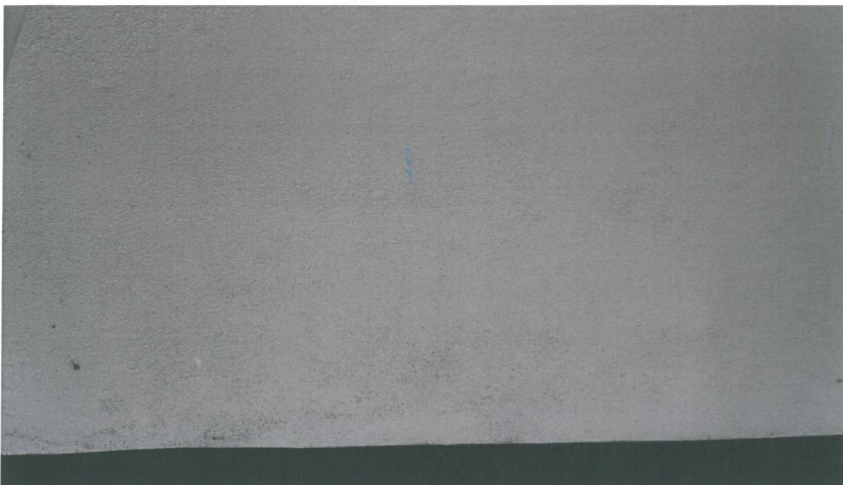
Fot. 155. Miejsce wyznaczone od odkrywki nr II na estakadzie zachodniej gdzie nie występują widoczne uszkodzenia. Dokładną lokalizację zbrojenia wyznaczono za pomocą profometru.
