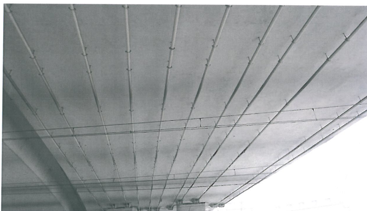
Fot. 15. Widok ogólny spodu konstrukcji przęsła skrajnego estakady zachodniej nad torami kolejowymi. Ustrój nośny wzmocniony za pomocą sprężenia zewnętrznego.
