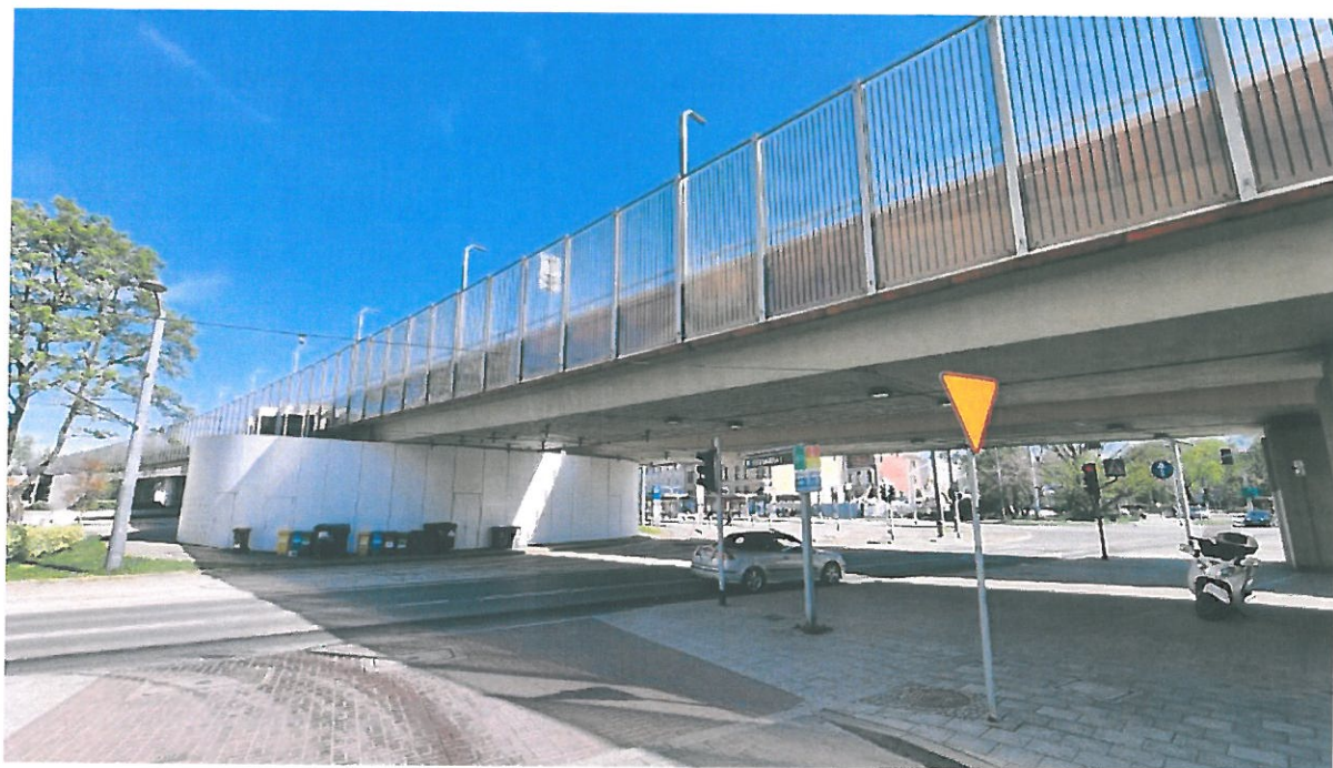
Fot. 10. Widok estakady zachodniej z boku między podporami P12, P13.
