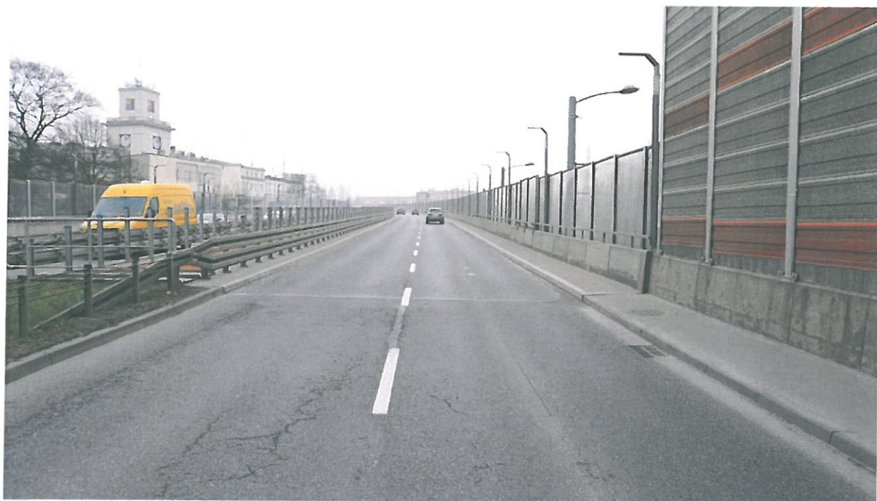
Fot. 4. Widok dojazd do estakady wschodniej patrząc w kierunku Bytomia.
