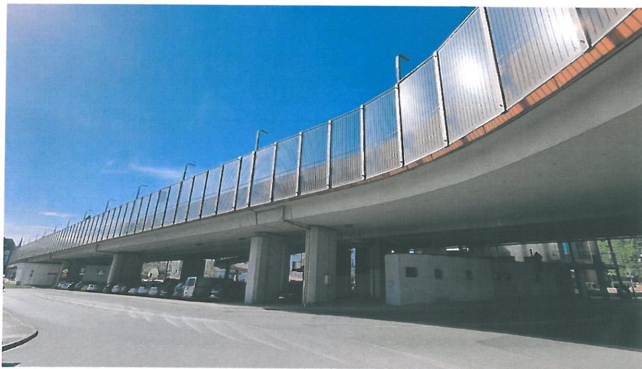
Fot. 1. Widok estakady wschodniej z boku między podporami P3, P4, P5, P6.
