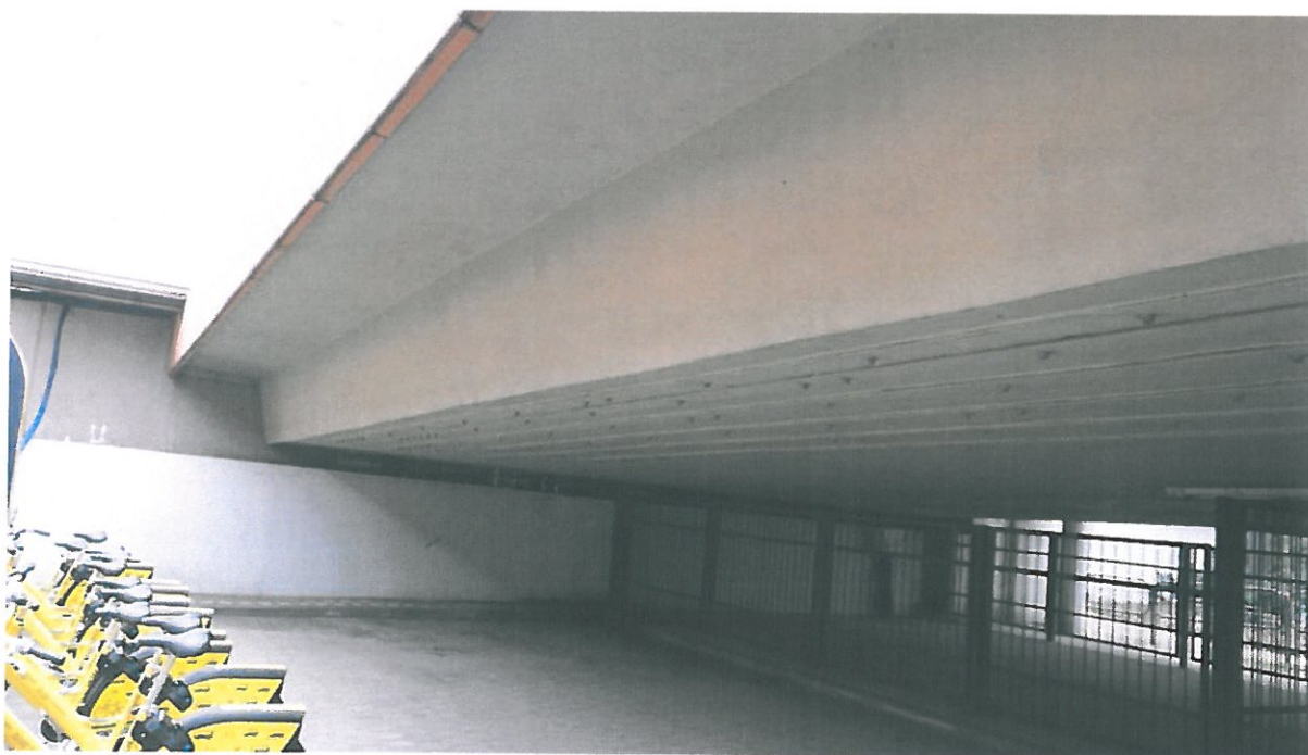
Fot. 17. Widok ogólny na przyciótek estakady zachodniej od strony Katowic.
