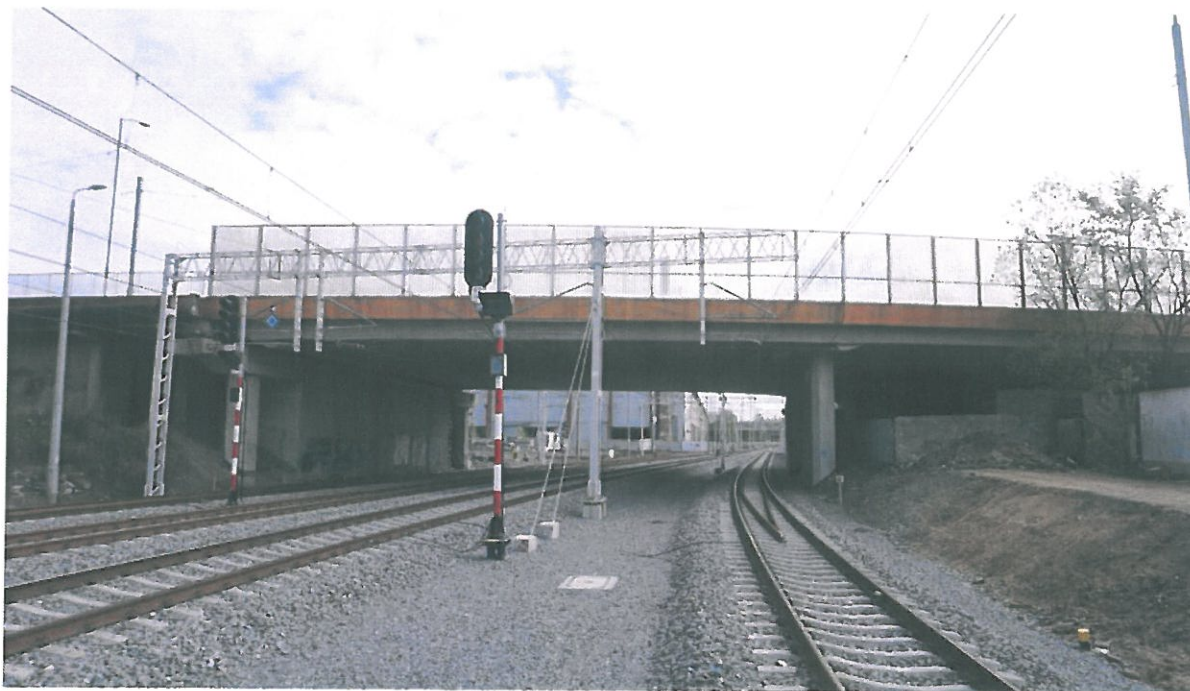
Fot. 12. Widok estakady zachodniej z boku, przęsło skrajne.
