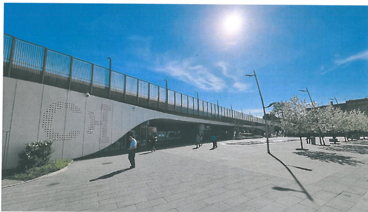
Fot. 11. Widok estakady zachodniej z boku między podporami P7, P8.
