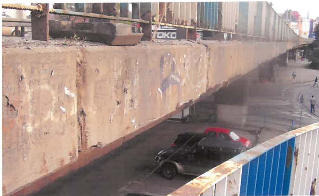
Rys. 8. Widok na gzymsy z pochylni dla pieszych w rejonie budynku poczty
