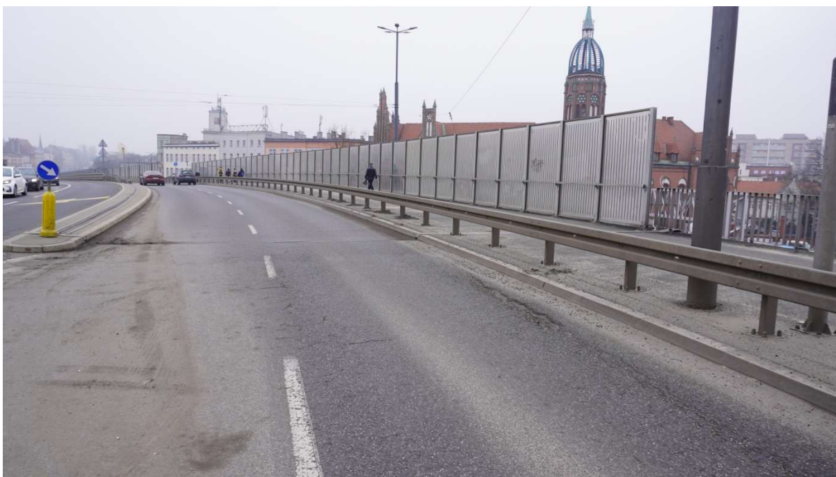
Fot. 14. Widok dojazd do estakady zachodniej patrząc w kierunku Katowic.
