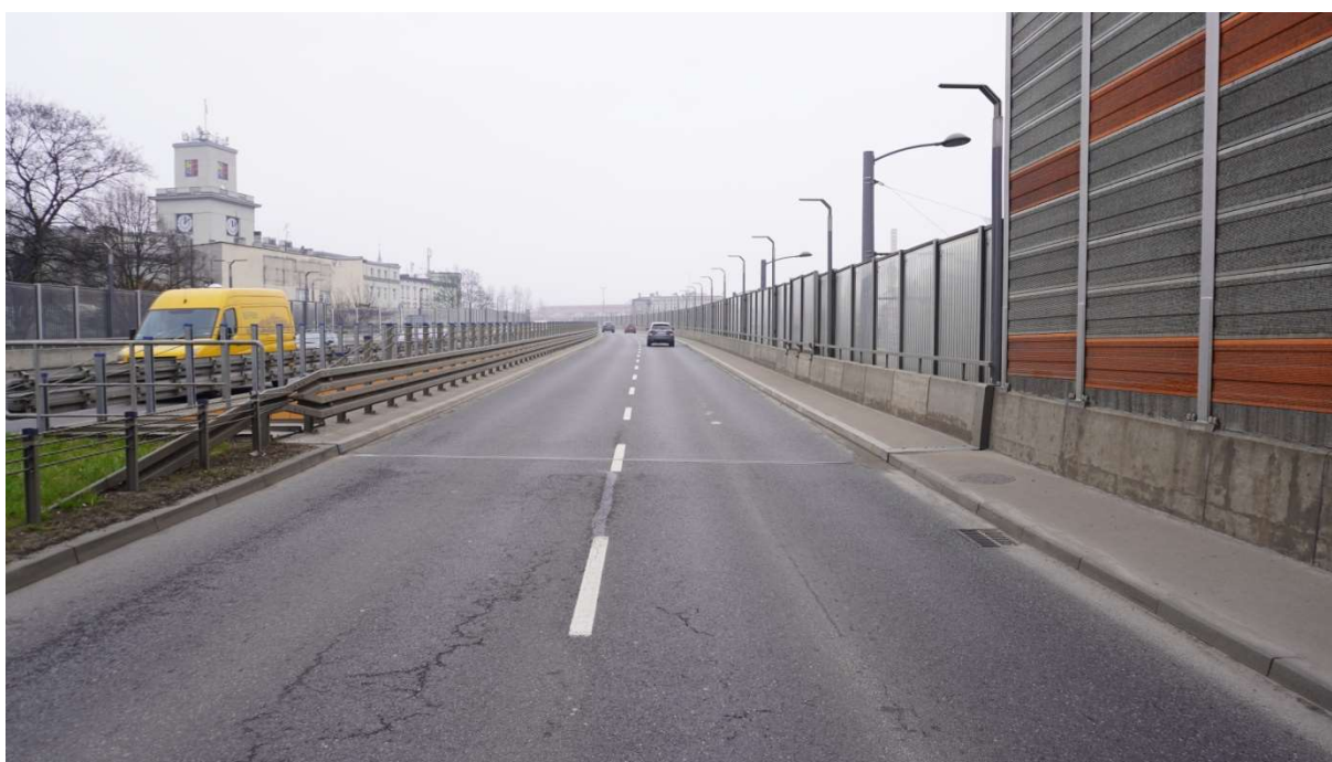
Fot. 4. Widok dojazdu do estakady wschodniej patrząc w kierunku Bytomia.
