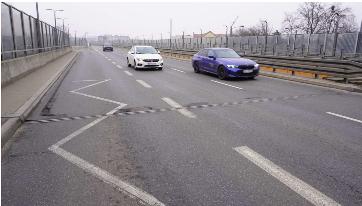
Fot. 13. Widok dojazd do estakady zachodniej patrząc w kierunku Bytomia.
