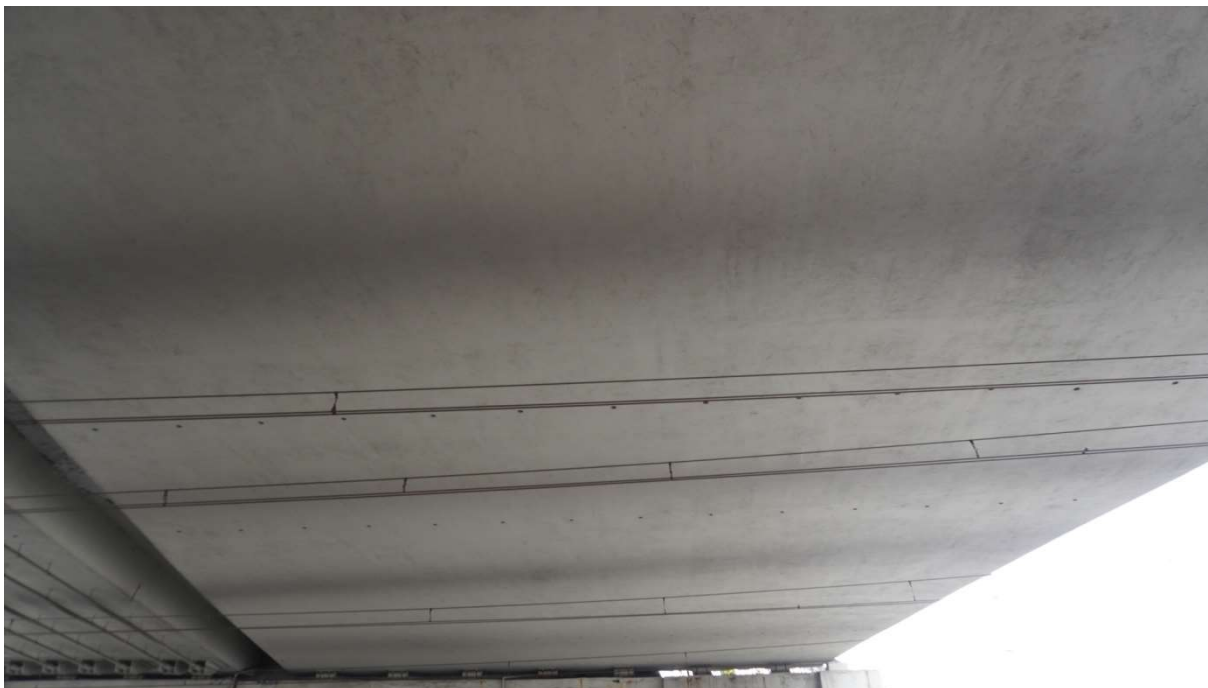
Fot. 7. Widok ogólny spodu konstrukcji estakady wschodniej w przęśle I.
