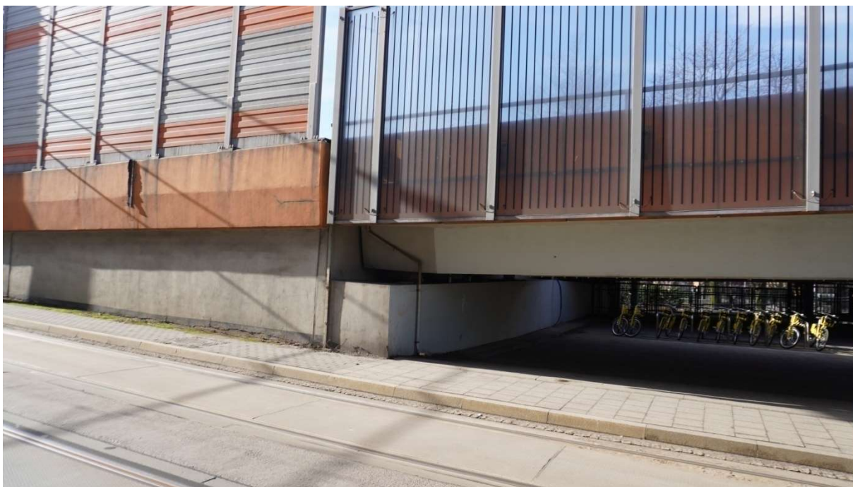
Fot. 8. Widok ogólny na przyczółek estakady wschodniej od strony Katowic.
