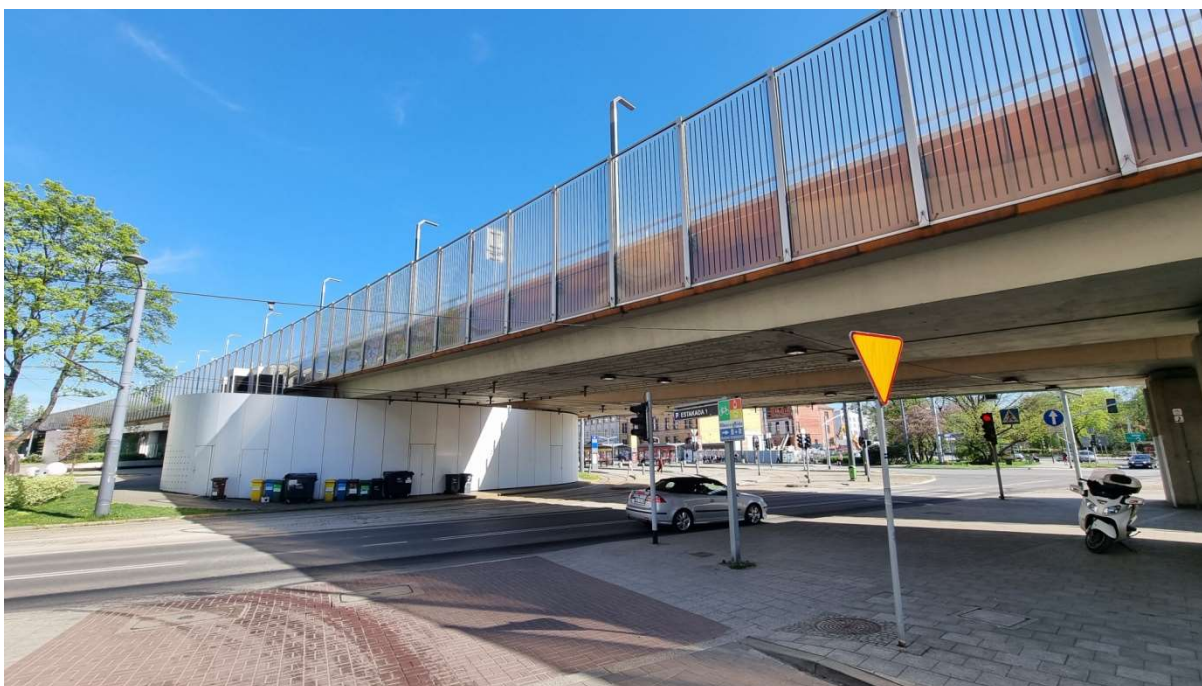
Fot. 10. Widok estakady zachodniej z boku patrząc w kierunku wschodnim w przęśle XII.
