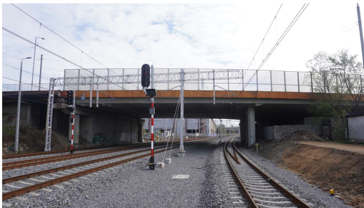
Fot. 12. Widok estakady zachodniej z boku patrząc w kierunku wschodnim w przęśle I, II.
