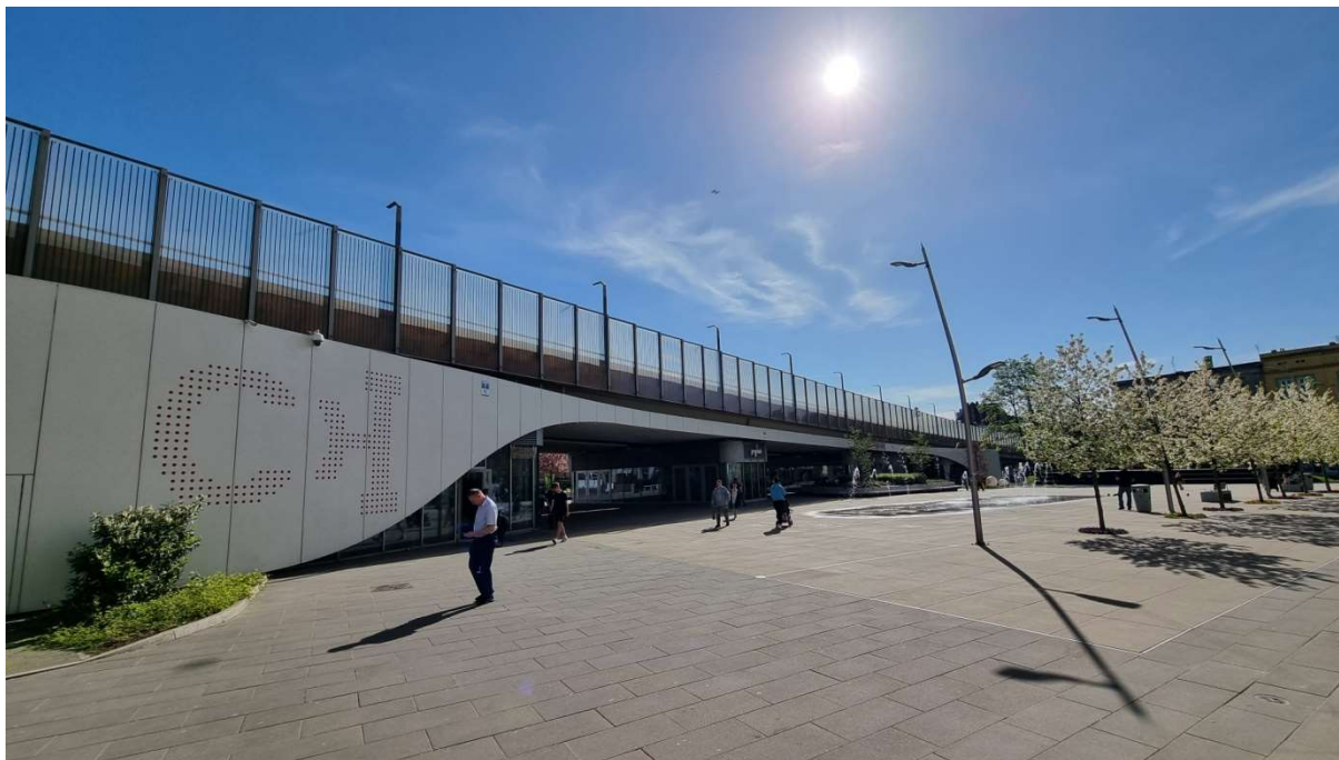
Fot. 11. Widok estakady zachodniej z boku patrząc w kierunku wschodnim w przęśle V.
