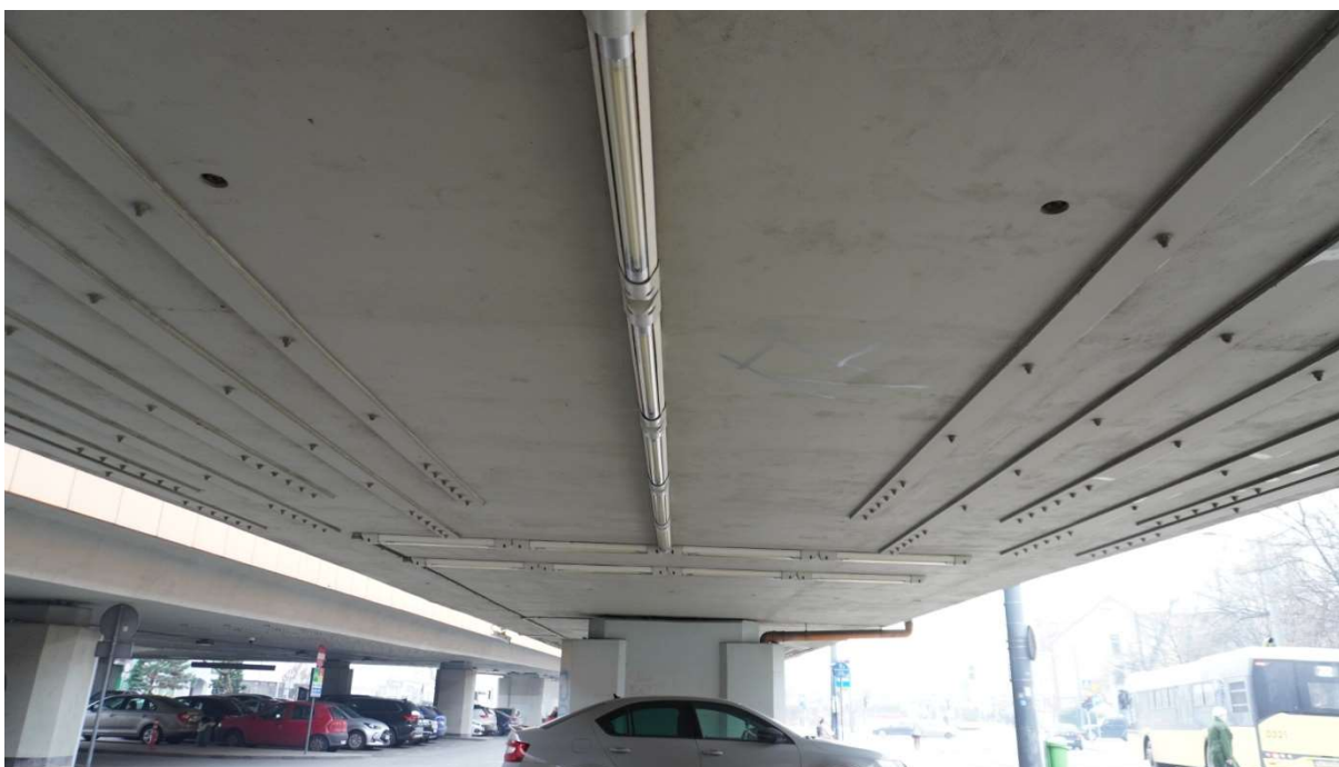
Fot. 6. Widok ogólny spodu konstrukcji estakady wschodniej w przęśle XIV. Na spodzie ustroju nośnego widoczne stalowe elementy wzmacniające.
