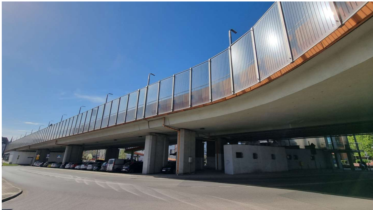
Fot. 1. Widok estakady wschodniej z boku patrząc w kierunku zachodnim, przęsło III, IV, V.
