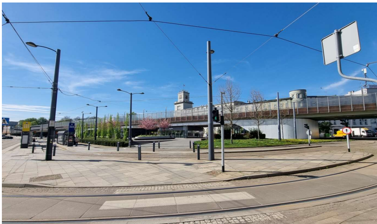
Fot. 2. Widok estakady wschodniej z boku patrząc w kierunku zachodnim, przęsło VII, VIII.
