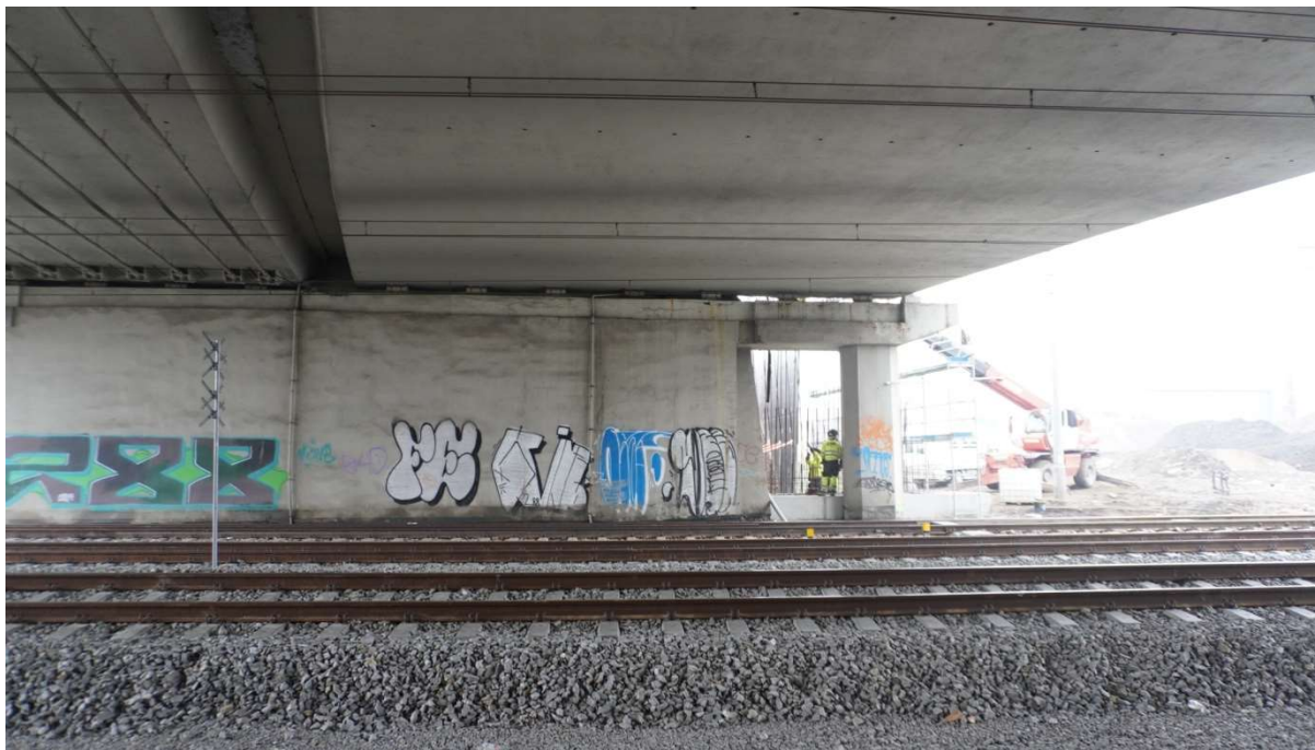
Fot. 9. Widok ogólny na przyczółek estakady wschodniej od strony Bytomia.
