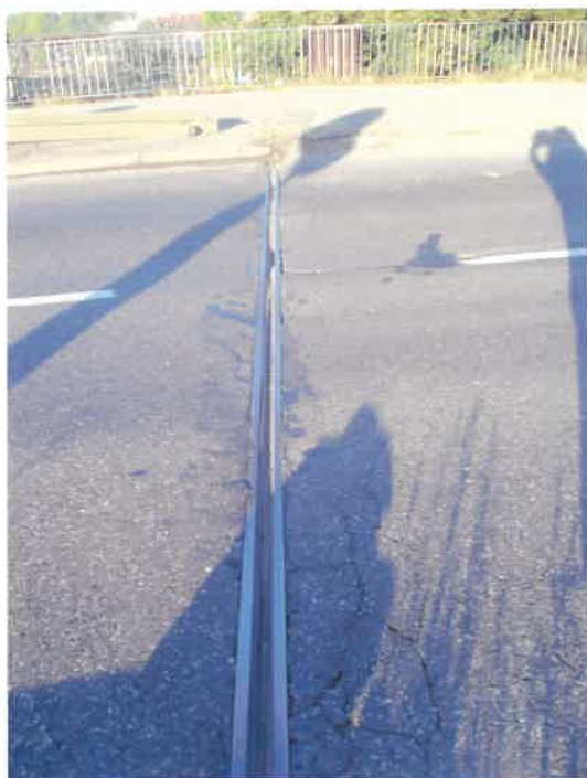
Fot. 19. Dylatacja od strony Bytomia. Widok dylatacji na jezdni i chodniku od strony poczty.
