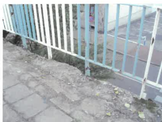
Fot. 40. Balustrada na chodniku od strony Huty
