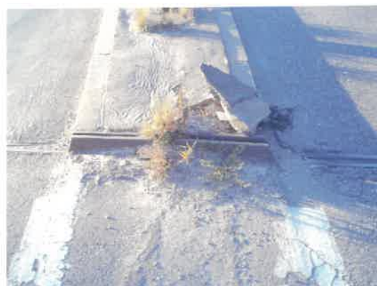
Fot. 18. Dylatacja od strony Bytomia. Widok dylatacji przy pasie rozdźiału. (Fot. arch. 65)
