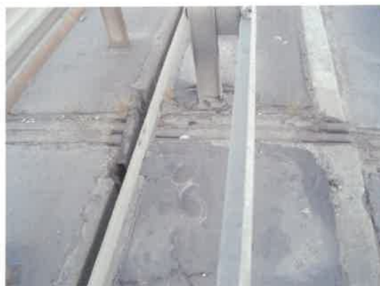
Fot. 24. Dylatacja w osi 3 – 4. Widok dylatacji przy pasie rozdziału.
