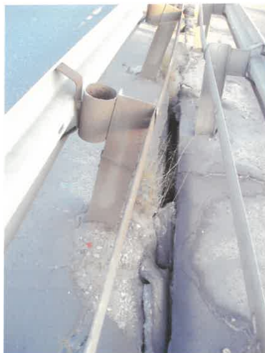
Fot. 38. Bariery energochłonne w rejonie dylatacji podłużnej
