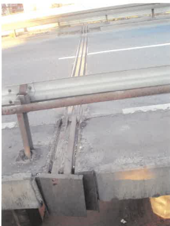
Fot. 27. Dylatacja w osi 9 – 10. Nitka Bytom – Katowice. Widok na osłonę pionową dylatacji.
